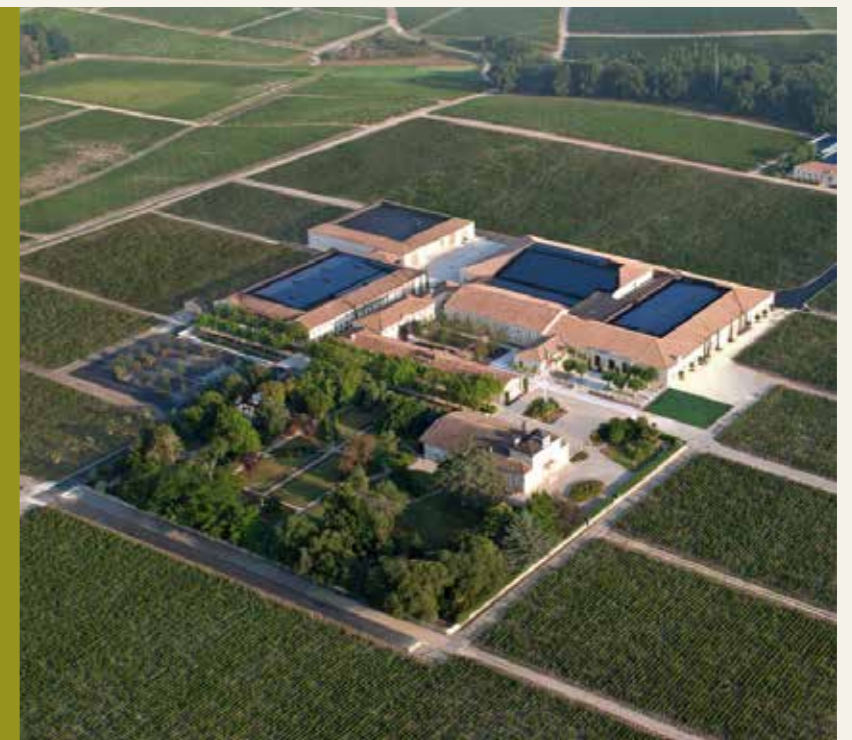
Le Château Montrose à St Estèphe (FR), qui conjugue efficacité de l'enveloppe, thermorégulation et production propre en énergies renouvelables. (Photo : chateau-montrose.com)
